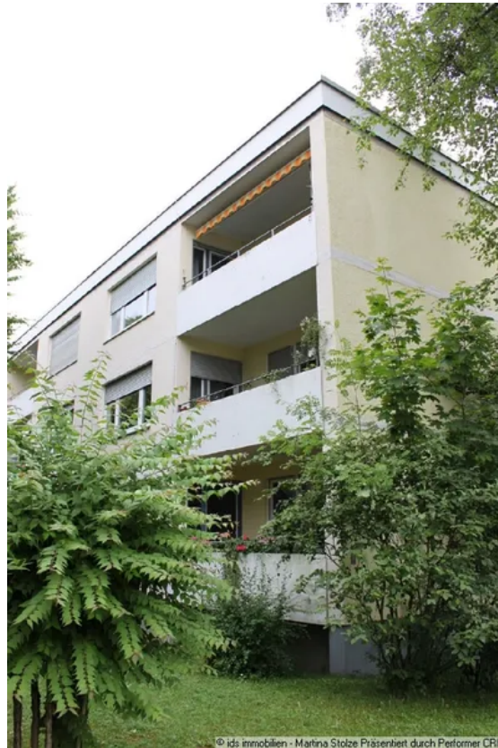
Aussenansicht Südseite mit Loggia
